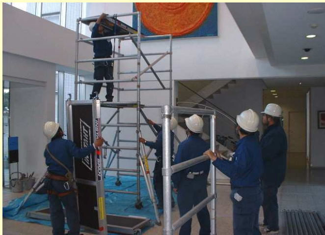
組立・解体作業も当社にお任せください。
