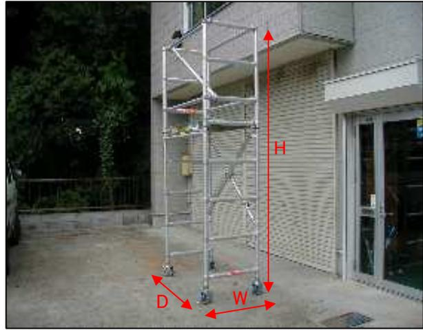
1段の設置寸法：877(W)×1490(D)×3280(H)
